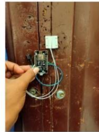
Pemasangan pada pintu
